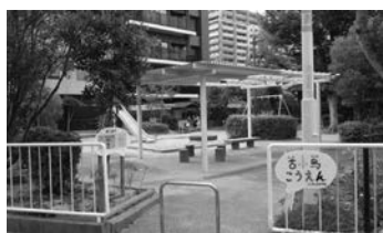
【写真2】 パーゴラ空間
